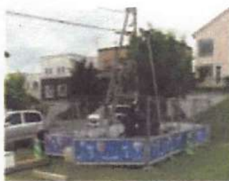
ボーリング調査状況写真
