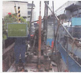
調査中（歩道内作業例）
